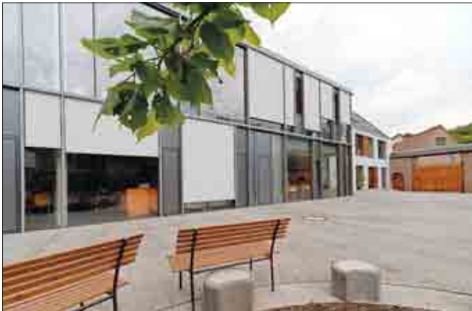
Das Schulgebäude der Gemeinschaftsschule „Maria Martha“ in Rastenberg.
