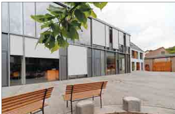
Das Schulgebäude der Gemeinschaftsschule „Maria Martha“ in Rastenberg.
