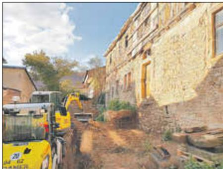
„Nach Abschluss der groben Arbeiten ist es vorgesehen, den Betonblock mit originalen Steinen und Materialien zu besetzen, sodass die Eingangstreppe schlussendlich wieder dem ursprünglichen Zustand nahekommt. Da sie einen zentralen Punkt des Denkmalwerts ausmacht, wollen wir so verhindern, dass
